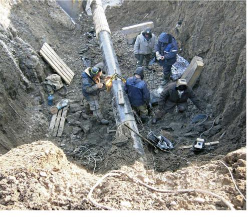
В процессе проведения подготовительных работ силами подрядной организации были сварены плети трубопроводов (сваренные в ряд несколько труб стандартной длины) для последующей их укладки в траншею. Качество сварных соединений контролировали специалисты ОАО «Норильскгазпром». После этого подрядчиком была произведена изолировка трубопроводов.
